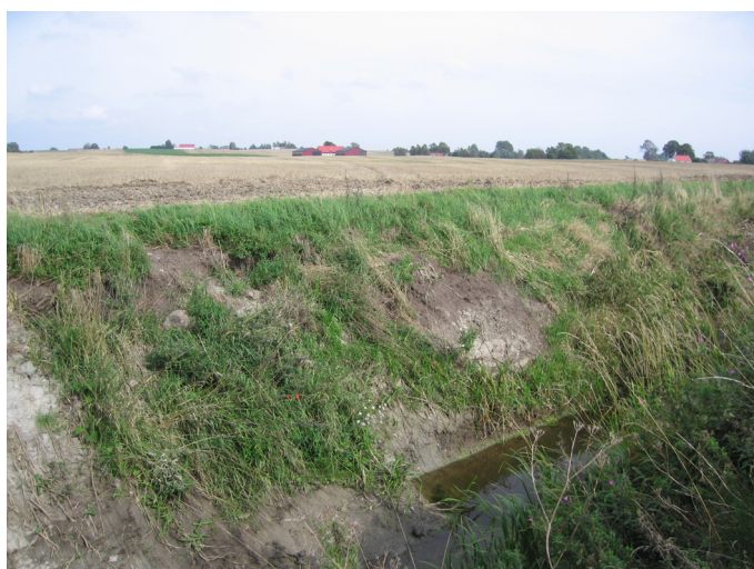
Branta strandkanter längs övre delen av Tullstorpsån som behöver fasas av, A-sträcka 54. Foto: Madeleine Wåland
